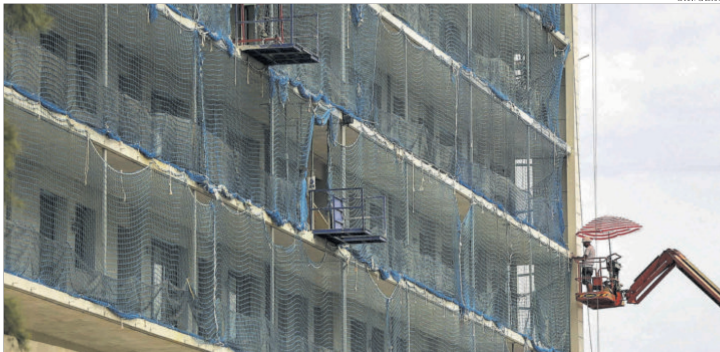
► Obra de vivendes a la zona pròxima al port de Badalona.
