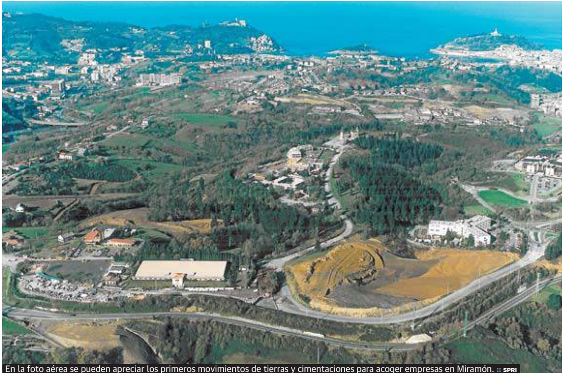
En la foto aérea se pueden apreciar los primeros movimientos de tierras y cimentaciones para acoger empresas en Miramón. :: SPRI
